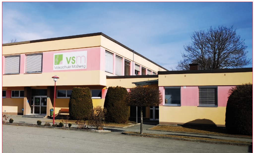
Die Lärmbelastung im Bereich Volksschule Maßweg ist so hoch, dass dort bei einem Neubau kein Schulbetrieb mehr zulässig wäre.
