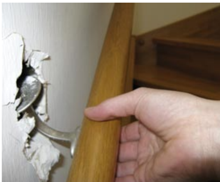
Mies montiert: Der Handlauf geht bestenfalls als Attrappe durch.
