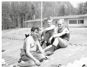
links Walter Degold, rechts Peter Janoschek beim Dachdecken des FD-Bufferes.
