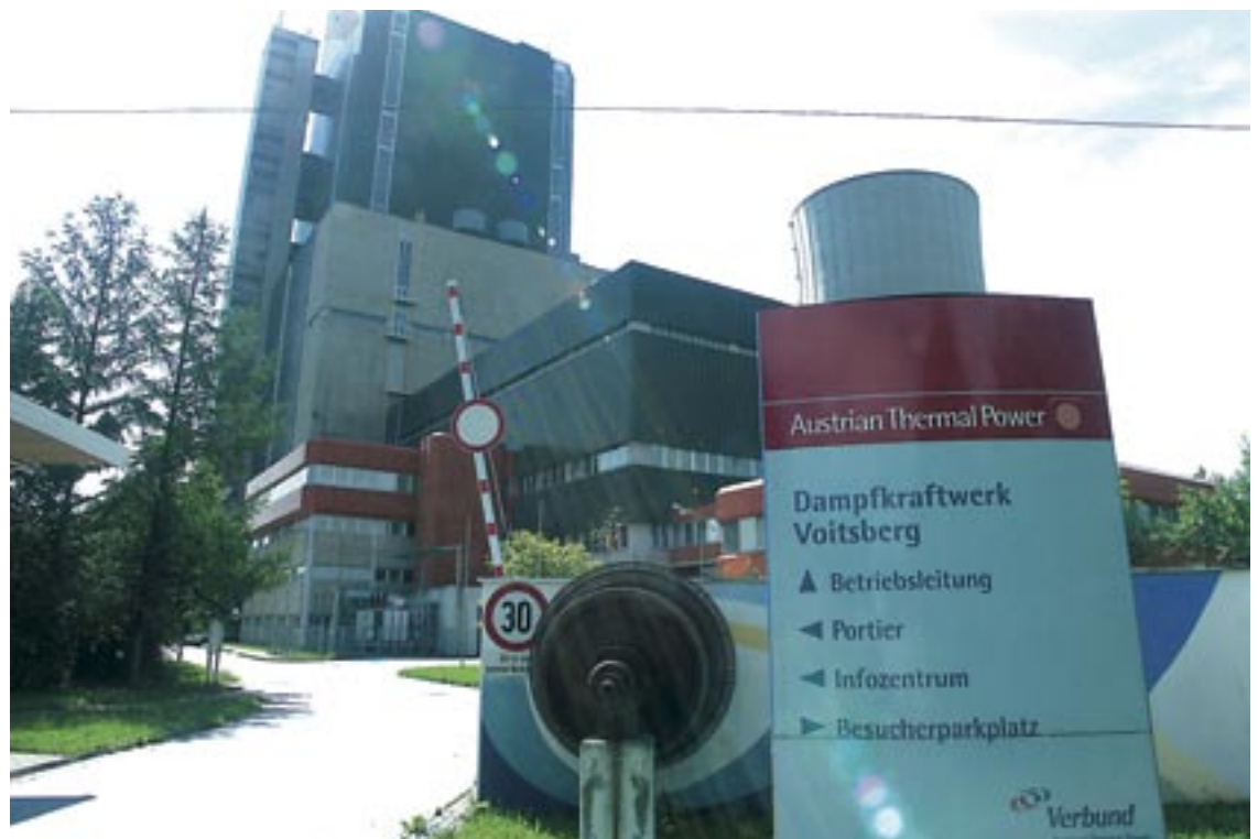
Das Voitsberger Kohlekraftwerk soll wieder aktiviert werden.
