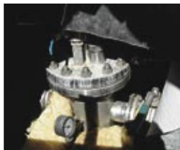
Wasserhahn Therme Fohnsdorf: Seit Jahren ist alles vorbereitet
