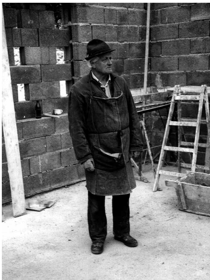
Feund Sandrieser am Bau.
